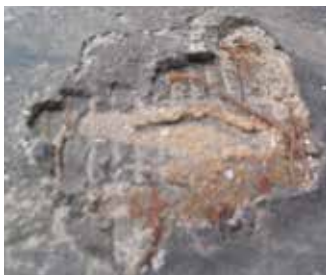
Przed: Wyżłobienie w taśmie
