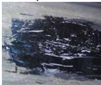
Po: Naprawa wyżłobienia z użyciem R-Flex
